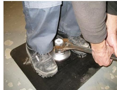
Rys. 4 – Demontaż SpotAnchor
